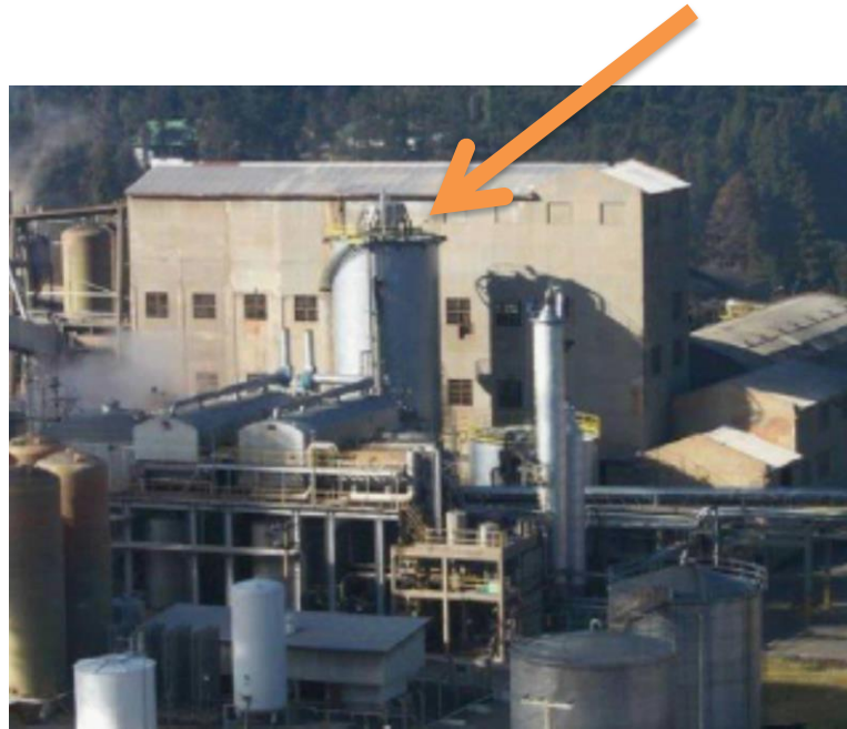
Reator anaeróbico da empresa Cambará S.A. – Brasil
