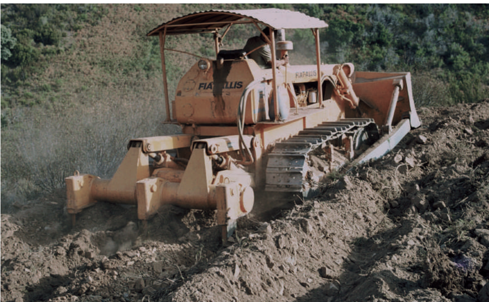
FIGURA 5.5 Ripagem contínua do terreno com três dentes em pequeno declive.
