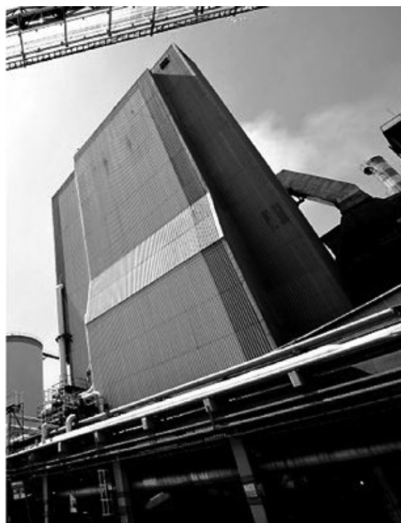
Caldeira de recuperação Kraft
