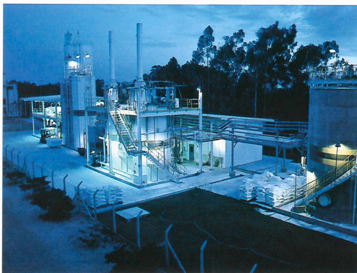
Fachada da fábrica da Specialty Minerals em Mucuri, BA. A empresa também possui unidades fabris nas cidades de Luiz Antônio, Jacareí e Suzano, no estado de São Paulo
