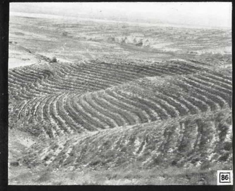
Fot. 82 e 83 — Ripagem efectuada com um tractor TD 20, segundo as curvas de nível, apenas nas linhas de plantação, nos terrenos esqueléticos de xisto da Mina de S. Domingos — Fot. do autor.
