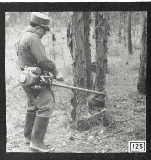
Fot. 125 — Segundo desbaste 5 a 6 anos depois, utilizando a serra rotativa — Fot. do autor.
