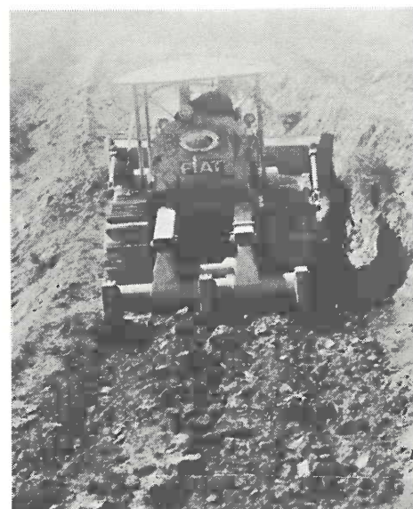
Fot. 81 — Remoção da terra a anglodozer para a construção dos terraços.
