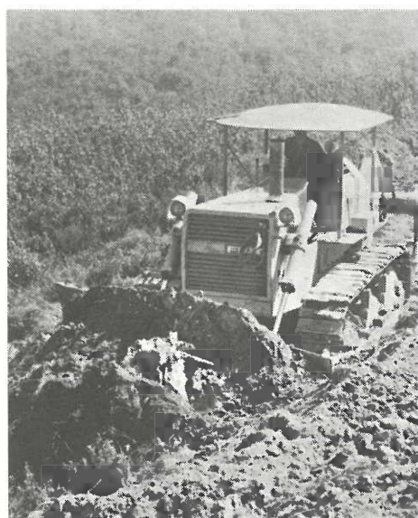
Fot. 81 — Remoção da terra a anglodozer para a construção dos terraços.
