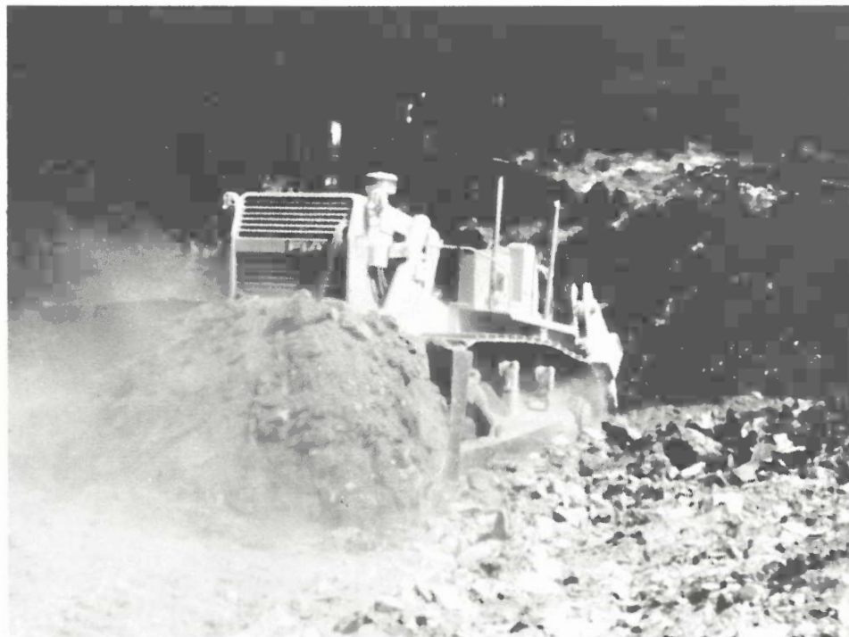
Fot. 67 — Abertura de caminhos em buldozer. Plantação da Serra d'Ossa.
