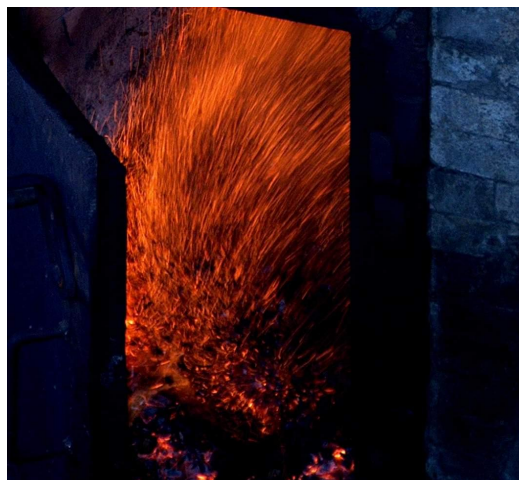
Combustão de madeira energética de acácia negra em uma caldeira
