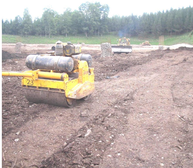
Lodos mesclados com cinzas e dregs/grits para facilitar compactação em aterros
