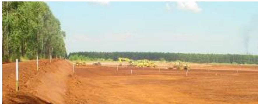
Compactação do solo na área de compostagem Fonte: International Paper do Brasil. Luiz Antônio/SP
