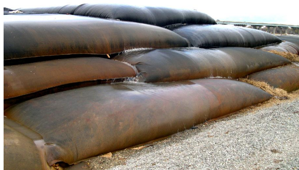
Geotubos ou bolsas de desidratamento e filtração de lodos
