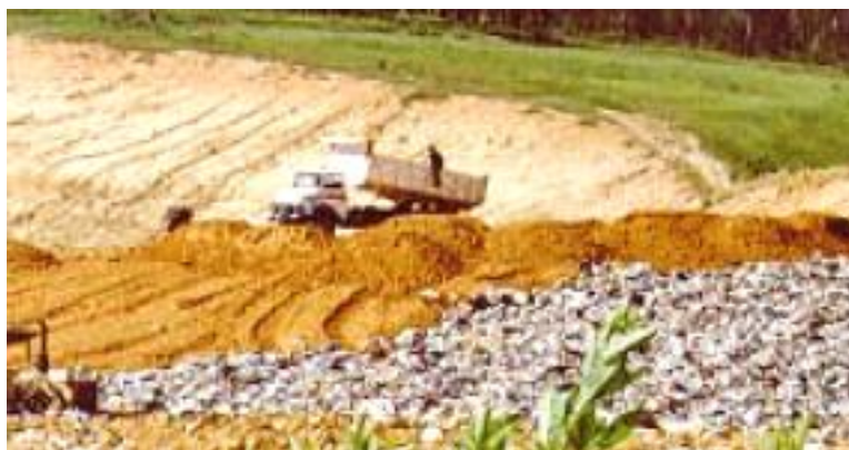
Lodo de ETA sendo usado para capeamento de aterros Fonte: Sabbag e Morita, 2003
