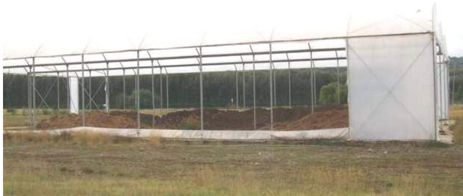
Estação de compostagem experimental. Fonte: CELCO-Arauco, Valdivia, Chile
