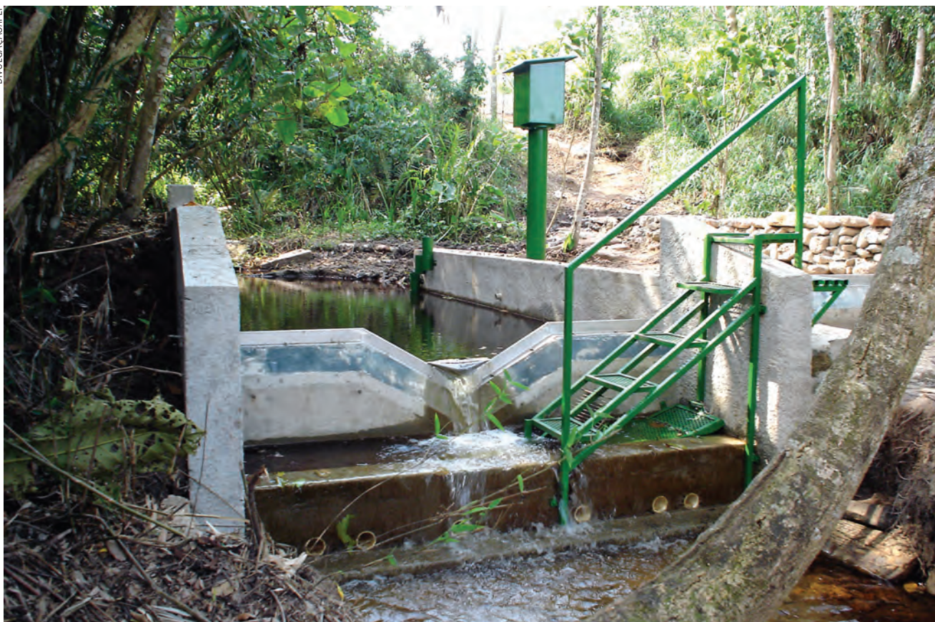
Vertedor da Fibria de Igaratá (SP) pelo qual é realizado o monitoramento hidrológico
