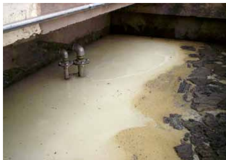
Figura 1: Inicio de flotación, se observa el aire disuelto.
