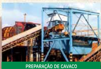
PREPARAÇÃO DE CAVACO
