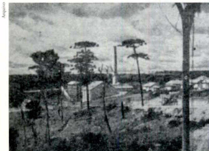
Vista geral da fábrica
