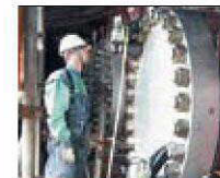
Serviço de Torque Controlado em Grandes Equipamentos
