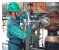
Serviços de Engaxetamento
