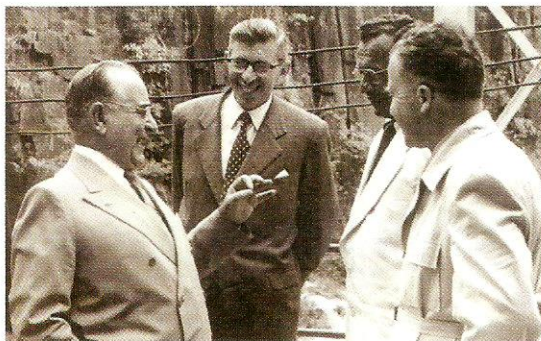
Na década de 1940, o presidente Getúlio Vargas visita a área onde estava sendo construída a usina hidrelétrica que recebeu o seu nome, inaugurada em 1953 e considerada, na época, a quinta maior do mundo.
