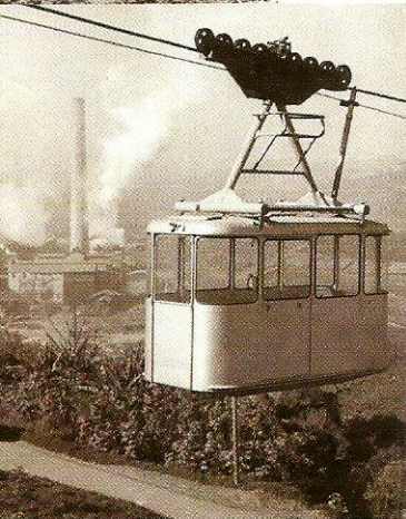
Bonde aéreo que transporta até hoje os funcionários entre a cidade de Telemaco Borba e a Klabin do Paraná, construído por uma empresa alemã. Inaugurado em 1959, o bondinho já transportou milhares de pessoas, sendo considerado na época o mais rápido e de maior extensão de vão livre do mundo, com 1.318 metros de comprimento e 76 metros acima do Rio Tibagi. Antes disso, para atravessar o rio, utilizava-se uma balsa ou uma ponte que fora construída pela Companhia Constructora Nacional SA.
