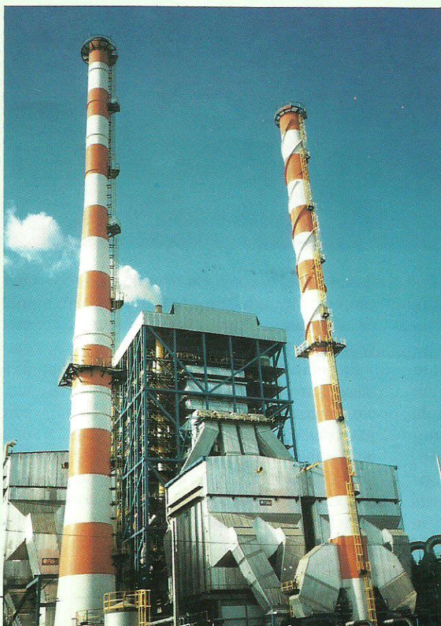
Precipitadores eletrostáticos para limpeza do ar da Bahia Sul
