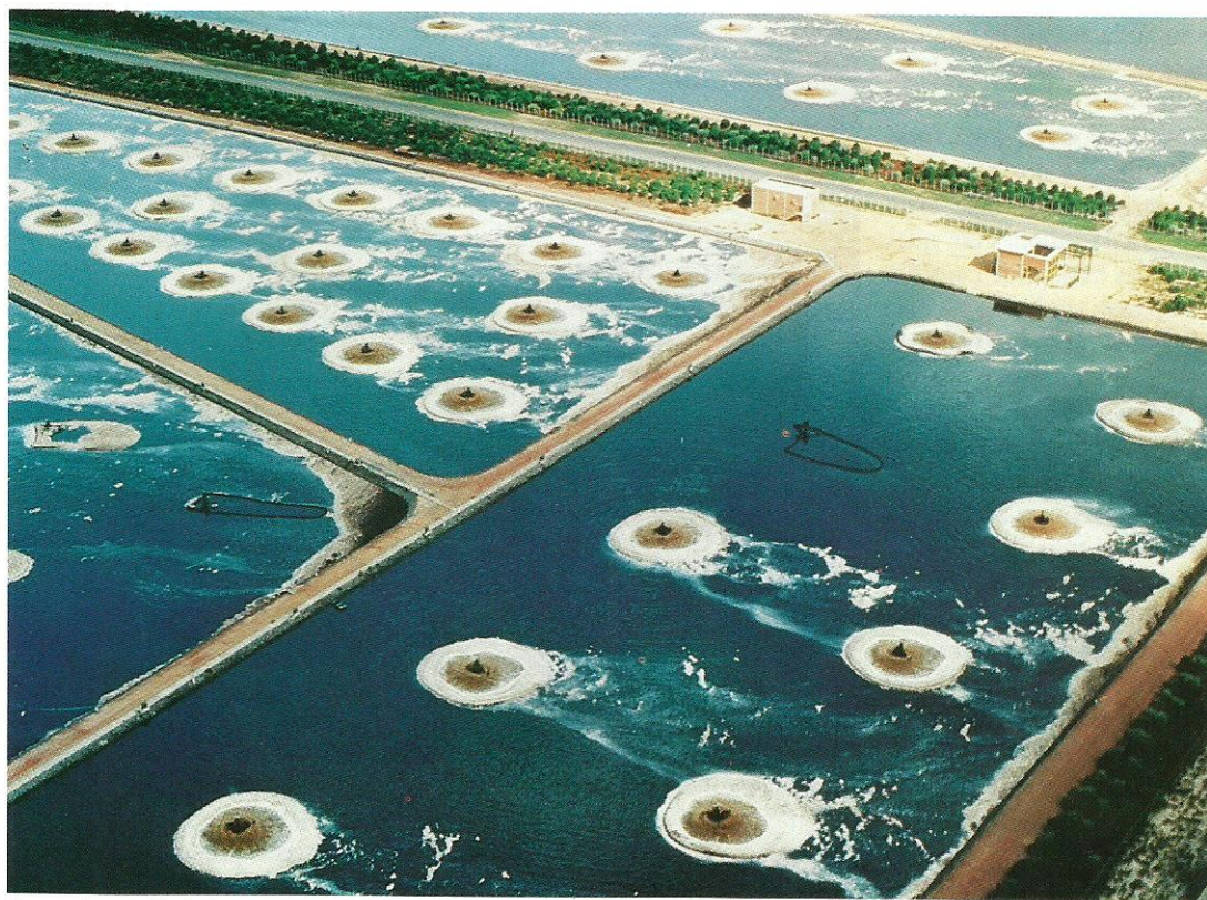
Lagoas de aerção da Aracruz, para tratamento dos efluentes
