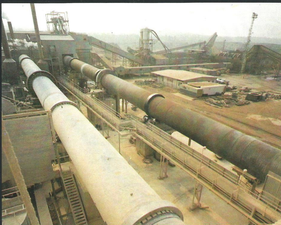
Forno Boliden Allis instalado nos Estados Unidos
