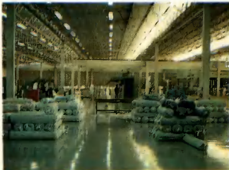
O Piso Strutural de superfície lisa e monolítica aplicado na Guararapes Têxtil S.A.
