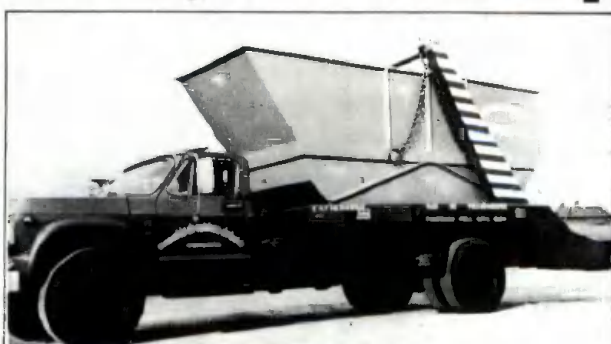
Modelo que opera caçambas ou recipientes de 7,5 até 17 m 3 para coleta de sisal nas fazendas. Sapatas Hidráulicas, articuláveis. CIA CELULOSE DA BAHIA - Camaçari - BA.
