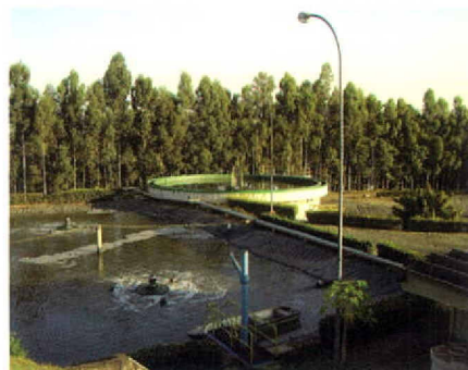
Decantador da estação de tratamento de efluentes, unidade Paulínia, Orsa Florestal
