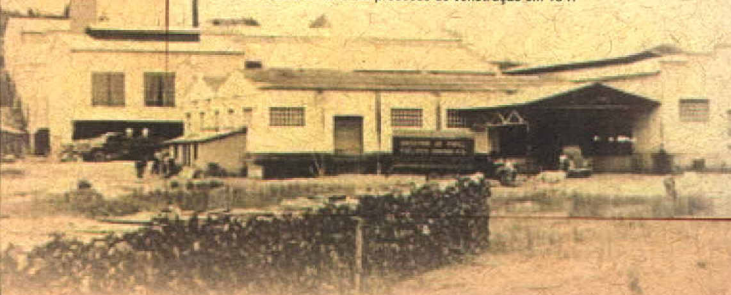
Fábrica da Suzano em processo de construção em 1947
