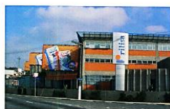
Novo centro de distribuição Ripasa, de 30 mil m²
