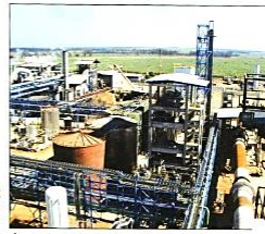
Área de Claustrificação e Forno de Cal em Montagem
