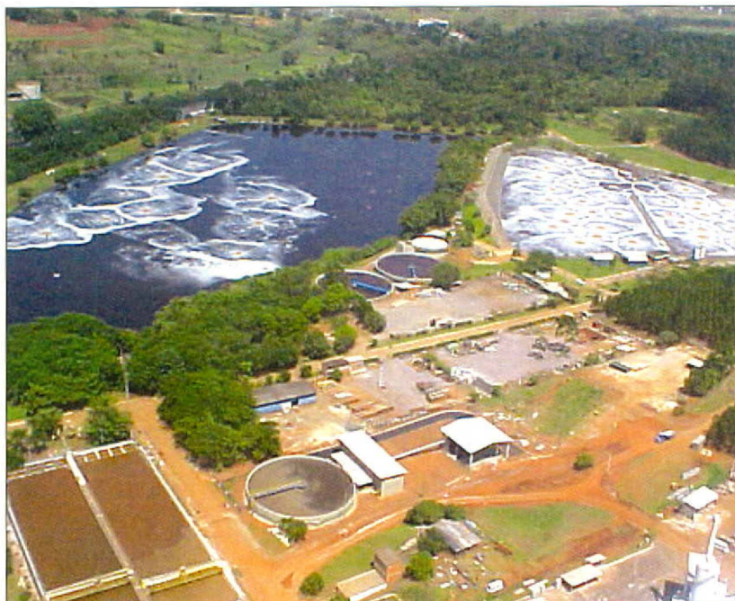
Estação de Tratamento de Efluentes da Ripasa em Limeira, SP
