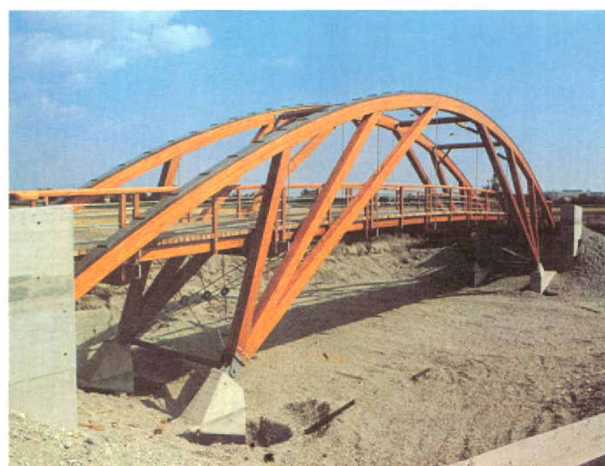
Exemplo de uso estrutural.
