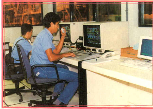
Sala de operações - parte úmida.
