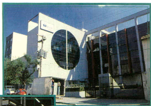
O parque gráfico está instalado em uma área de 28 mil m 2 .
